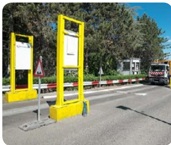
> Un portique de détection de radioactivité permet d'identifier d'éventuelles sources radioactives orphelines (huit sources ont pu être isolées en 2014).
