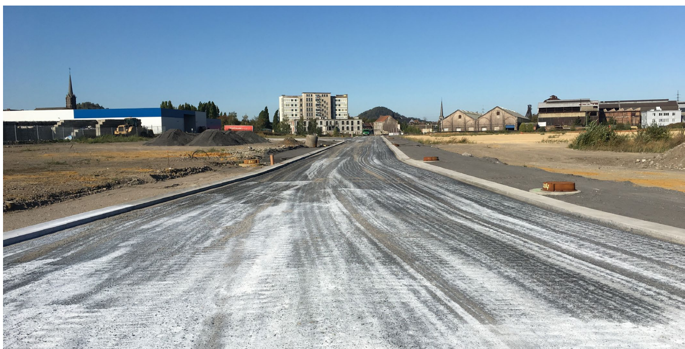
Réalisation de la phase 1 du projet de réaménagement
