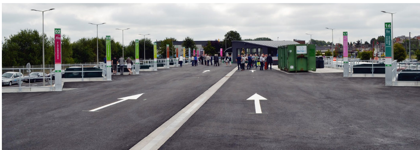
Recyparc de Pont-à-Celles le jour de l'inauguration du 25 juin 2018
